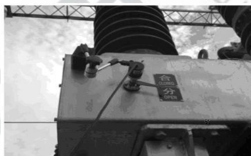
35KV SF6 开关传感器安装
